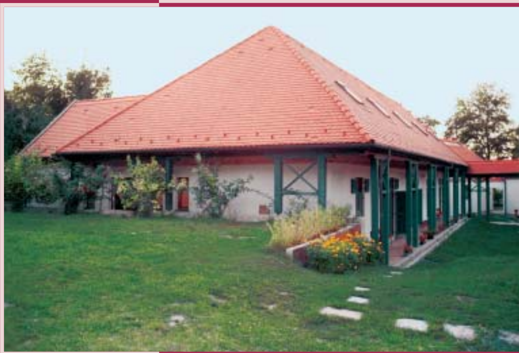
Árkádos belső udvar
